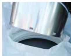
**4** Frein vapeur pour un raccordement impeccable et sûr de la couverture intérieure au côté intérieur du plafond.
